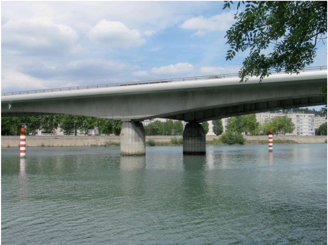
Piles, tablier et parapet, face amont (depuis la rive droite)
