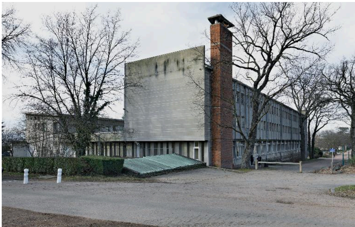
Bâtiment H1 : corps de bâtiment nord, depuis l'est
