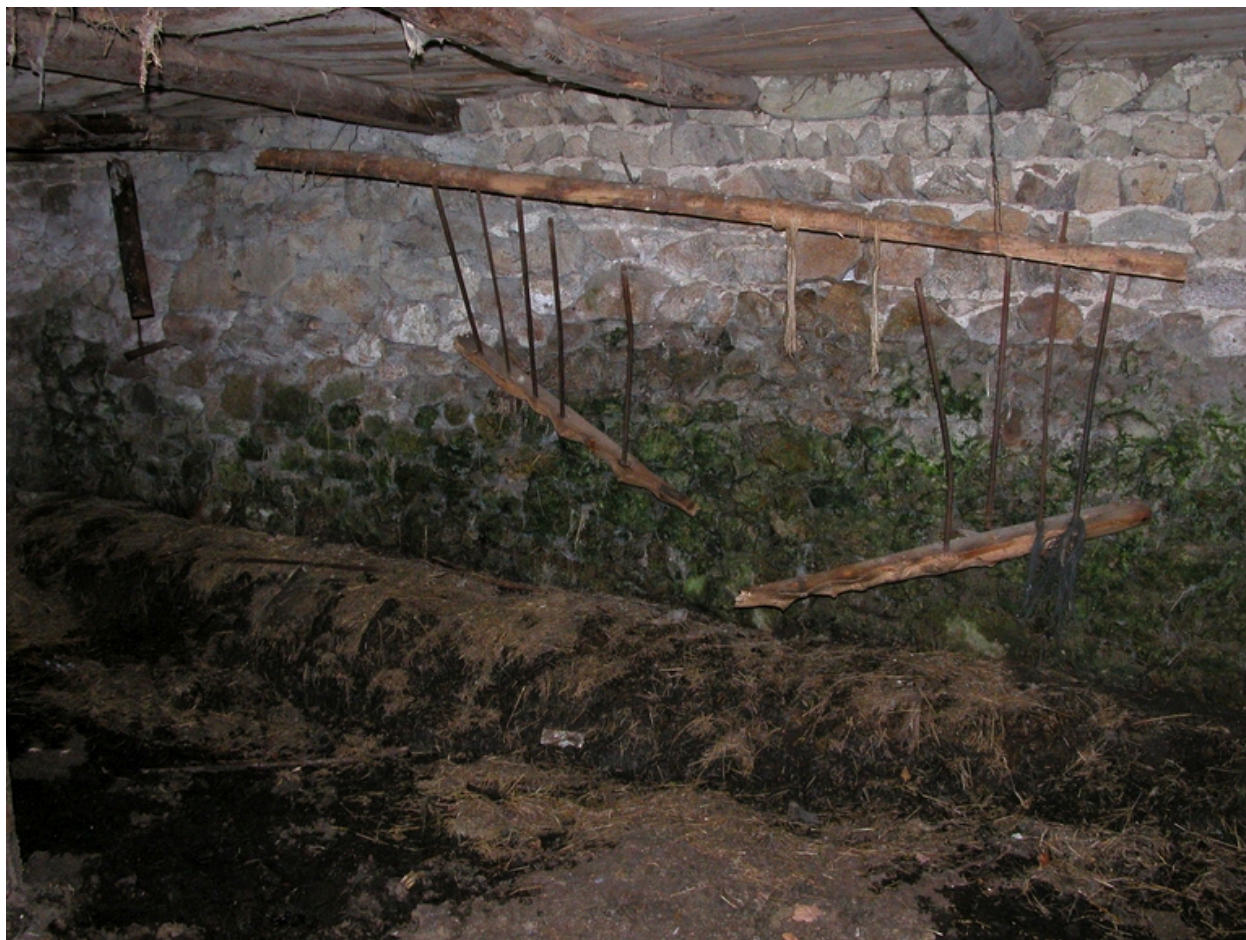
Vue intérieure du rez-de-chaussée.
