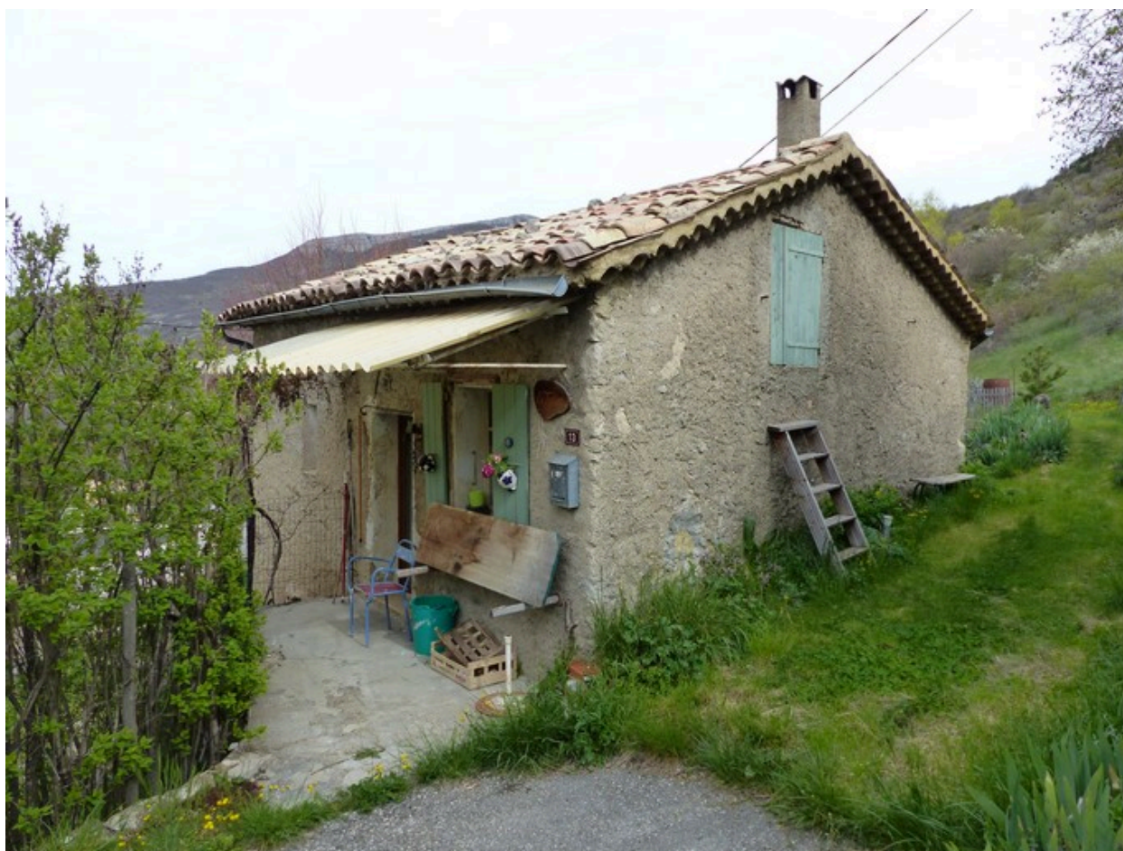
Vue d'ensemble prise du sud-est.
