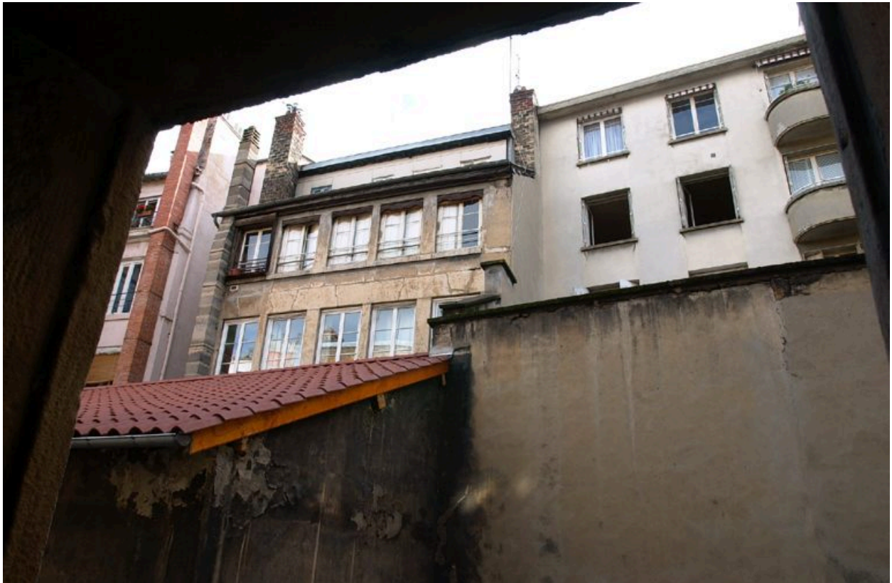
L'élévation postérieure depuis le 3e étage de l'immeuble accessible par le 5 rue Ferrandière (AE 53 sud)
