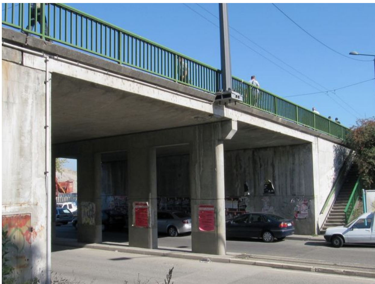
Culée de la rive droite, face amont
