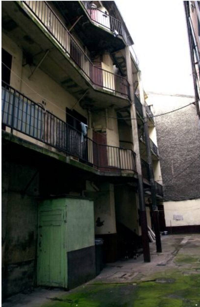
Elévation postérieure de l'immeuble sur rue, depuis l'est. Détail
