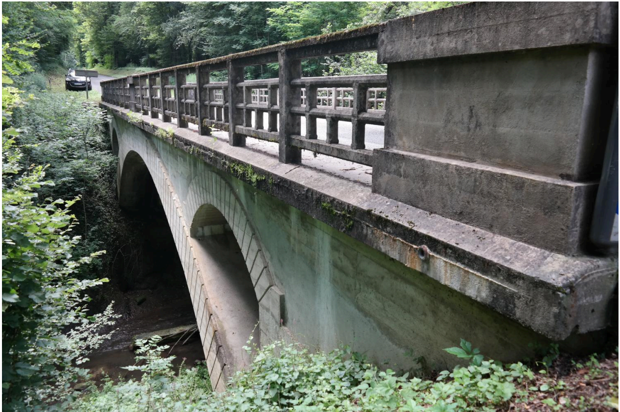
Pont du Parmand 1, vue de la face aval
