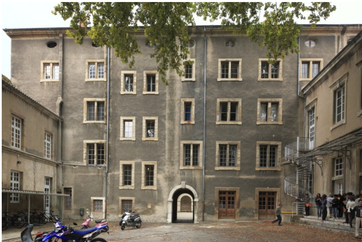
Bâtiment A, 16e siècle, façade sud sur cour intérieure.
