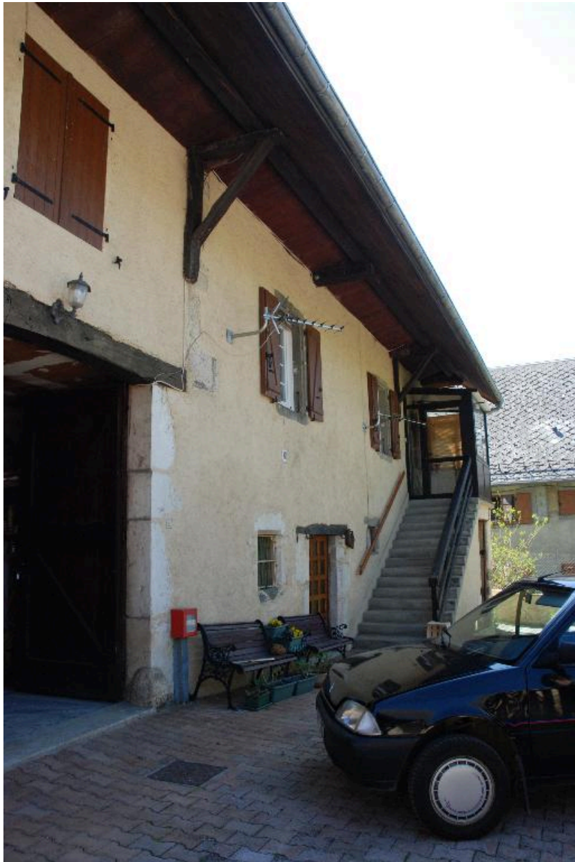
Les Farniers. Ferme, parcelle 2013 E1 398, élévation de la façade sur cour.
