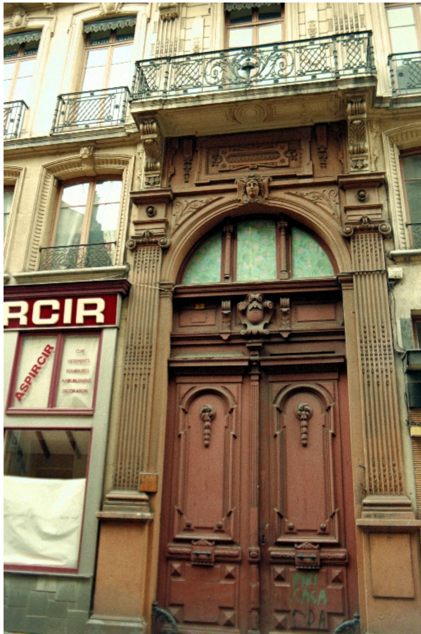
Façade principale. L'entrée
