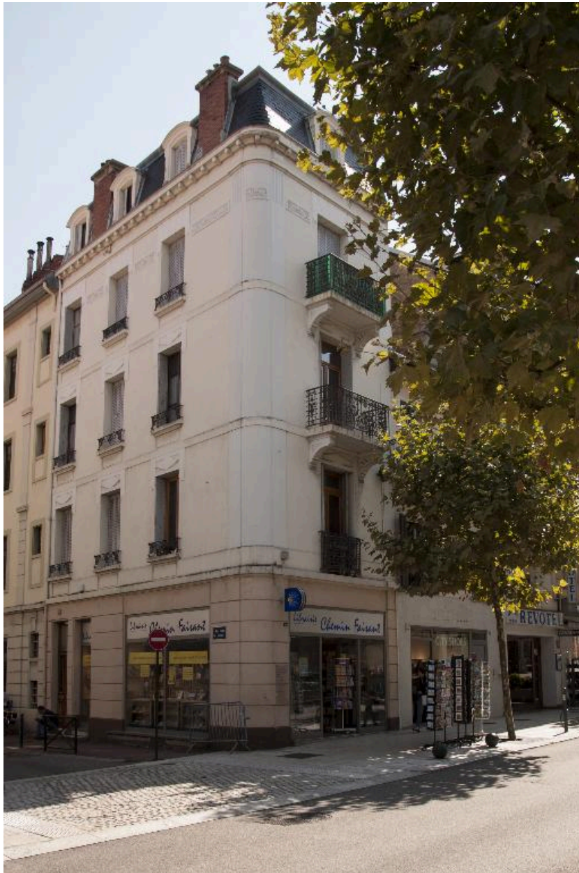
Vue de trois-quart depuis le nord-ouest
