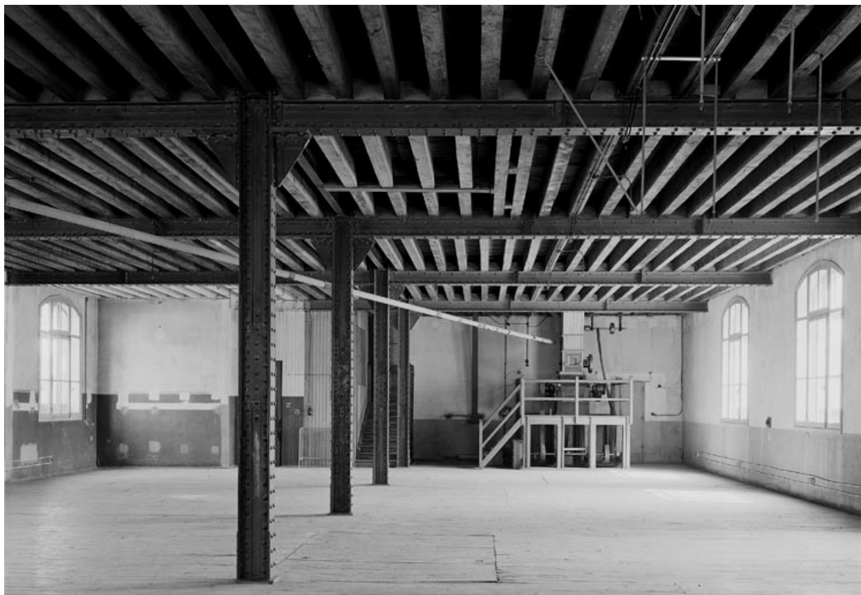
Atelier des moulins-broyeurs, vue ouest
