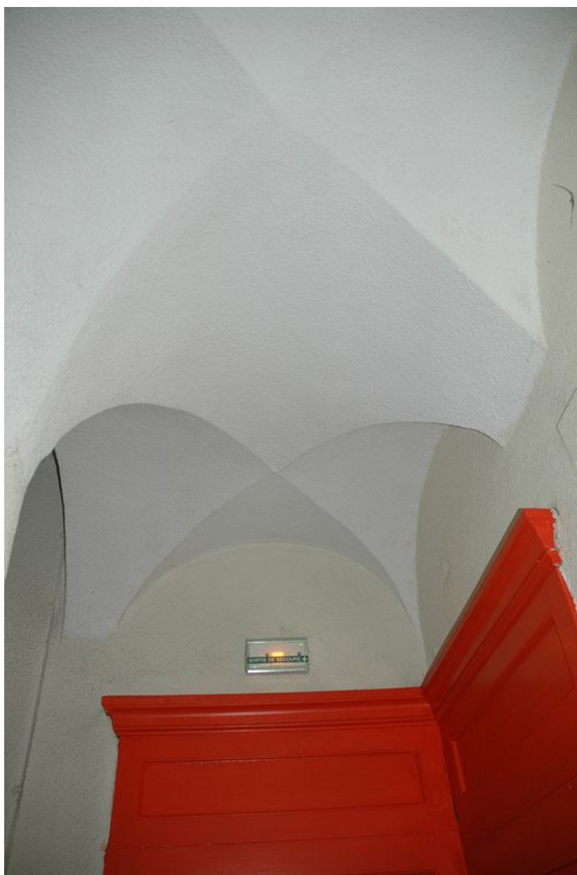
L'escalier : voûte d'arêtes couvrant le palier du premier étage
