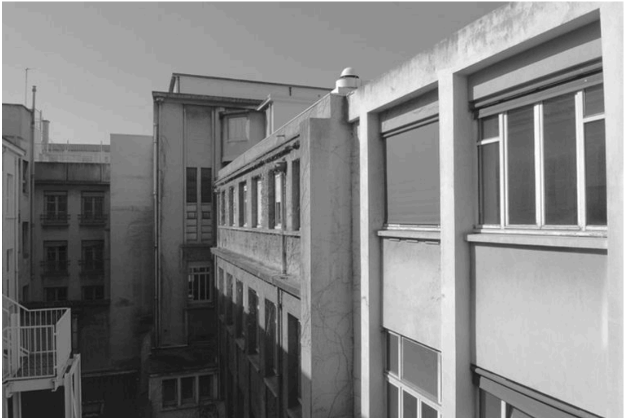
Bâtiment Leperc, élévation postérieure, détail dernier niveau
