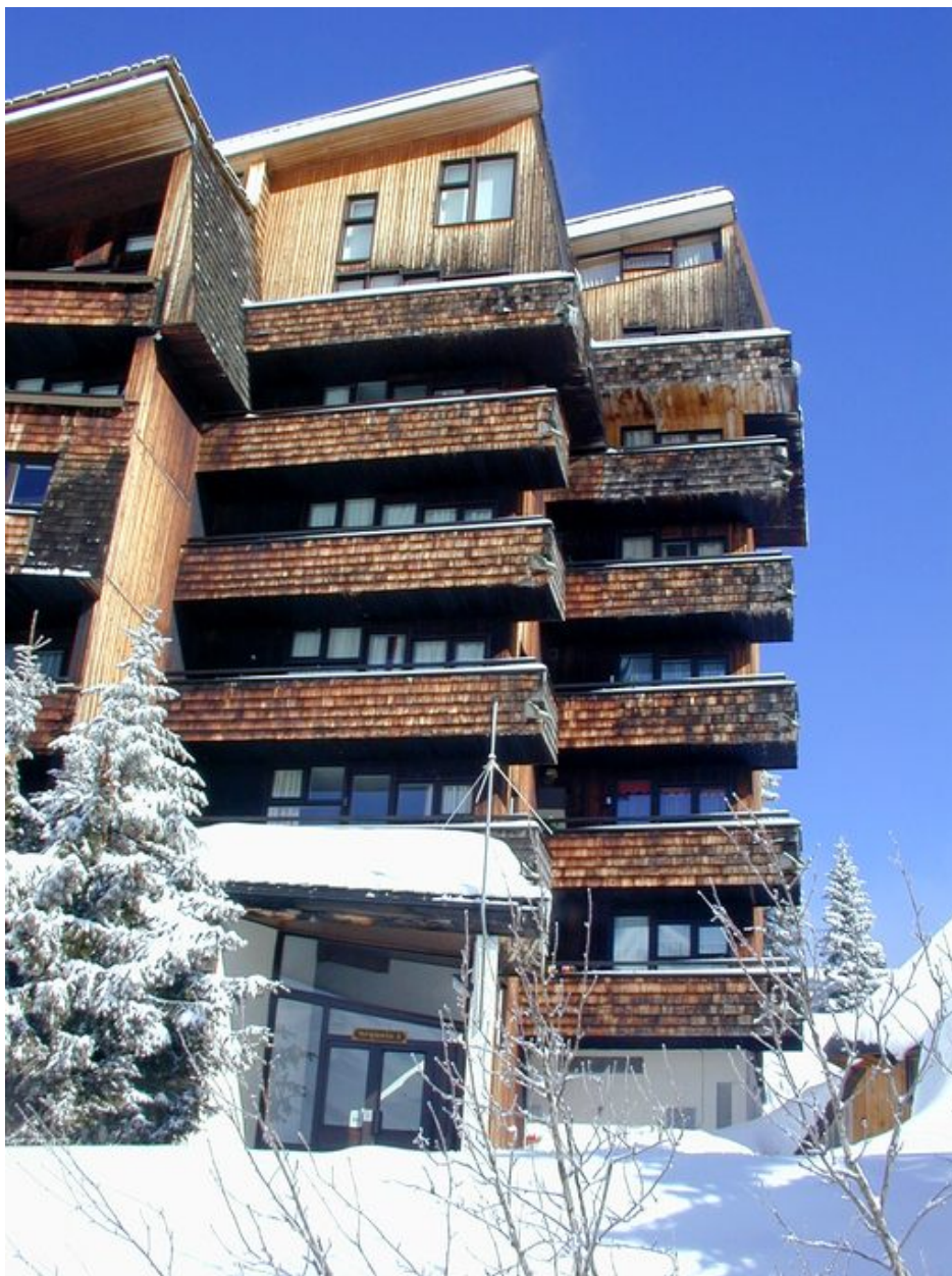
Vue du pignon est
