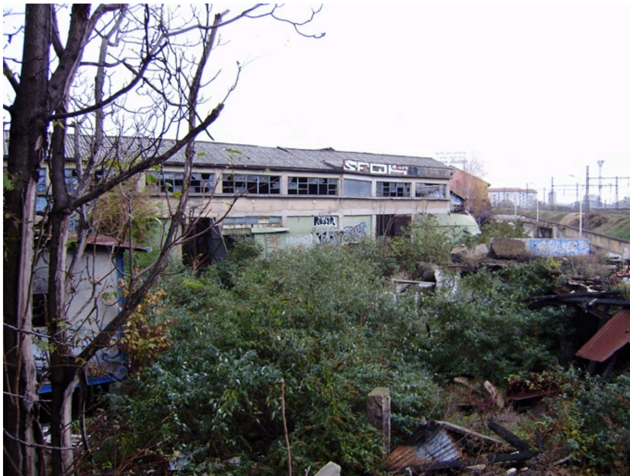
Vue d'ensemble ouest
