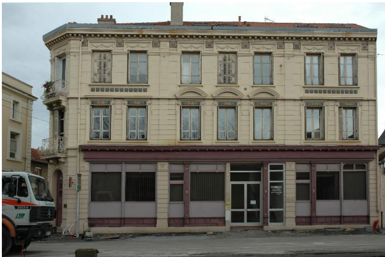
Immeuble, avenue de la Libération (BL 193)
