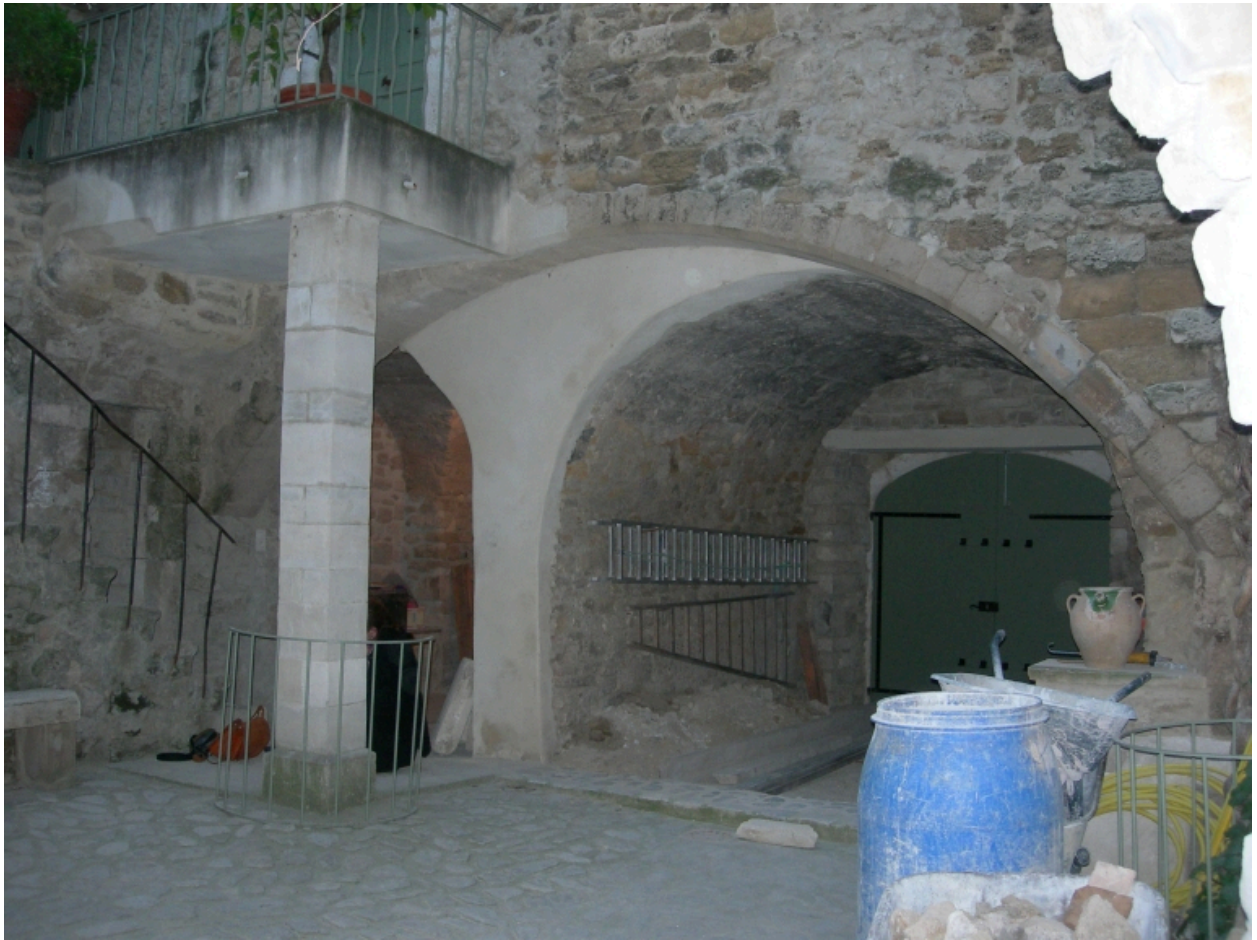
2e cour intérieure, à gauche (parc. D 196), angle nord-ouest : vue des deux passages voûtés.
