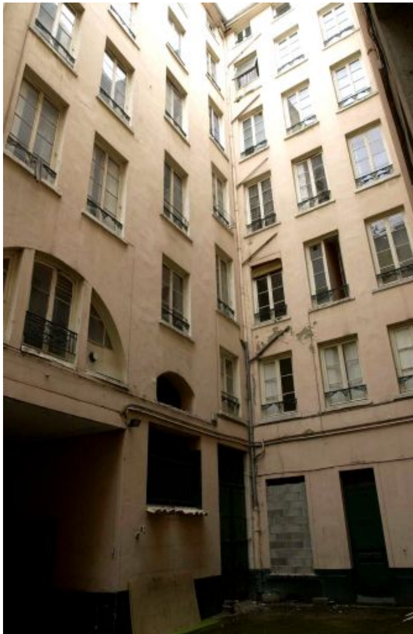
Vue de l'angle nord-est de la cour
