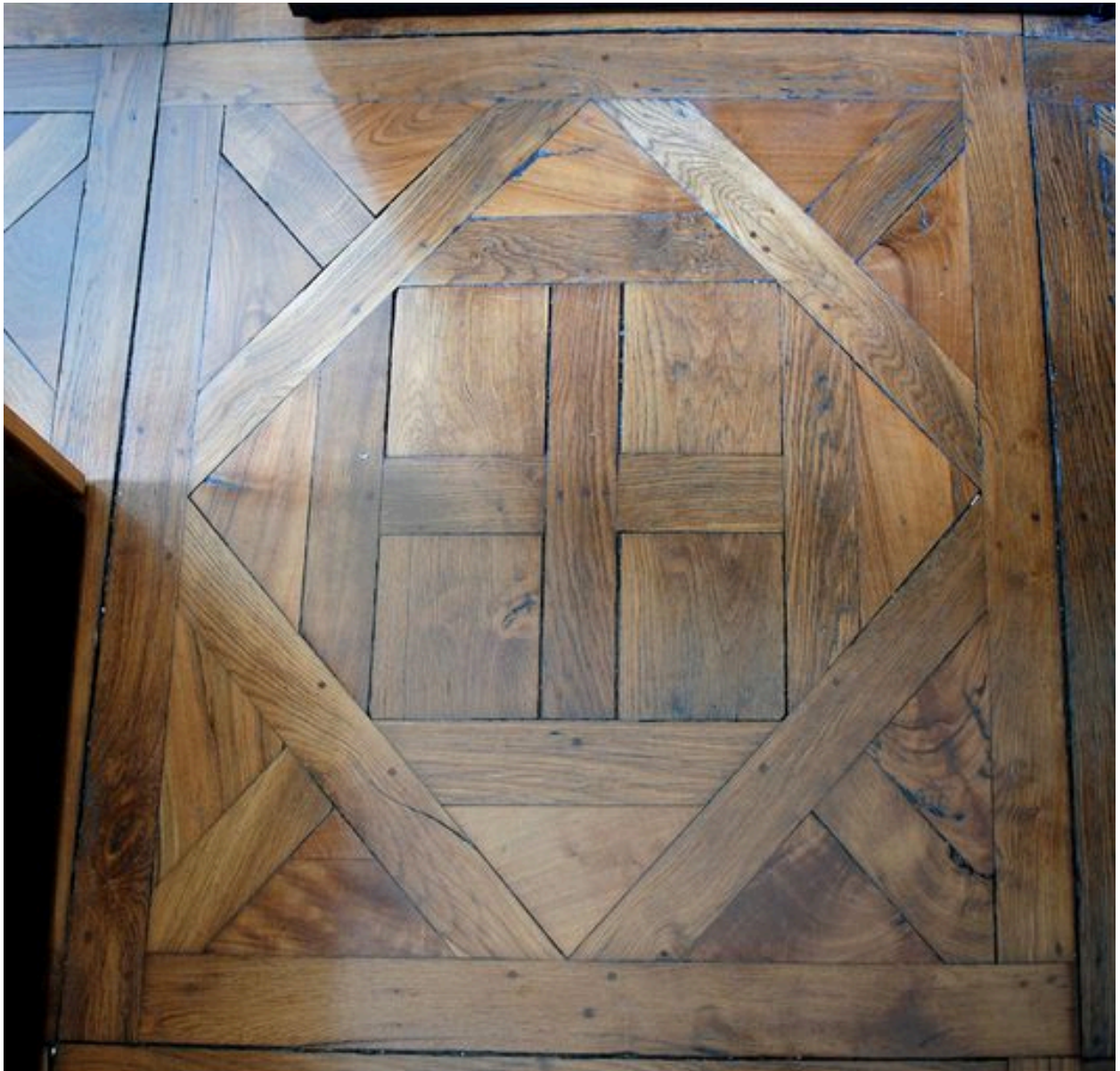
Bibliothèque, bureau du conservateur (partie conservée de l'ancien hôtel de Juys), détail du parquet.
