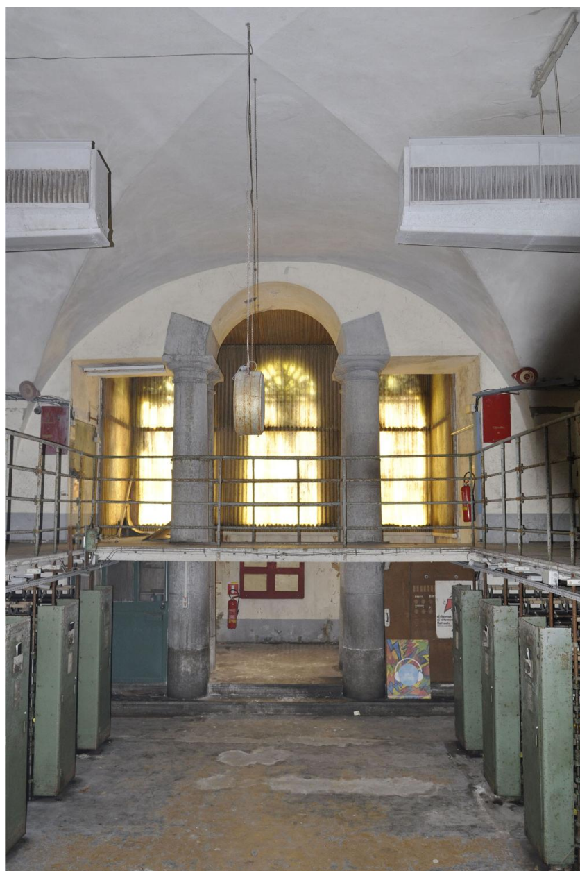
Ancien atelier voûté (vue d'intérieur)
