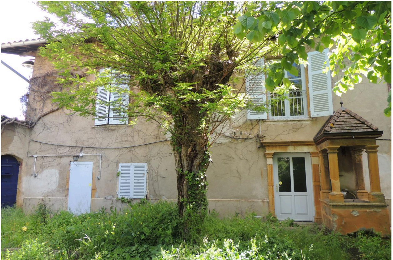
Façade sur jardin, partie nord-ouest.
