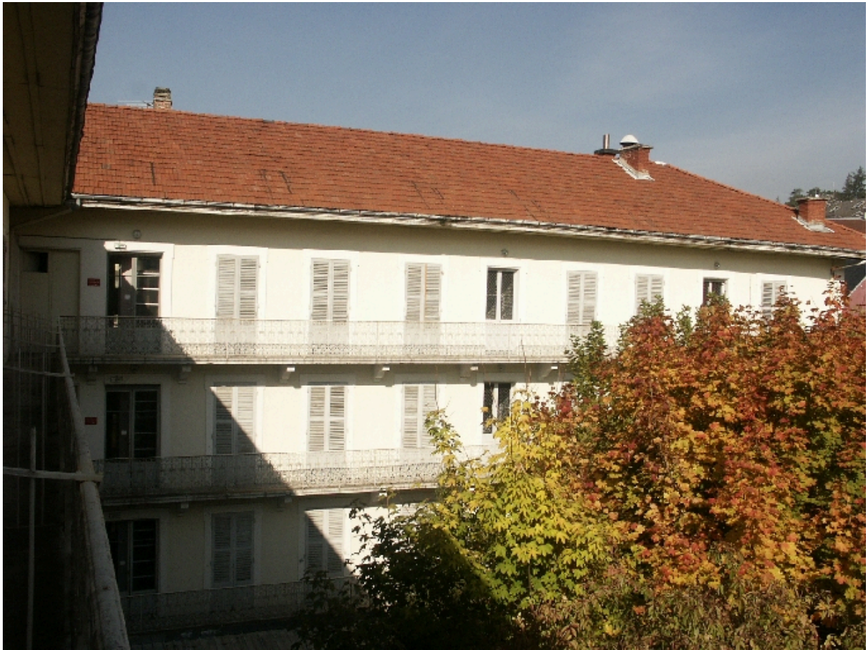
Aile nord : façade sur jardin
