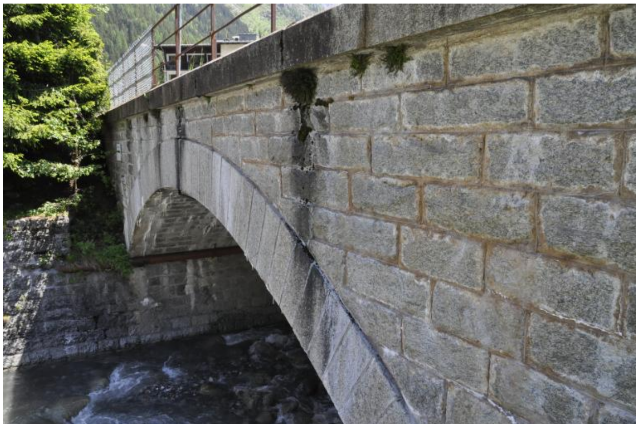
Détail du tympan amont et du bandeau de la voûte
