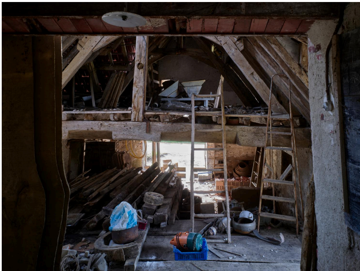
Intérieur de la partie dite du "moulin 1", vue du rez-de-chaussée et du comble.
