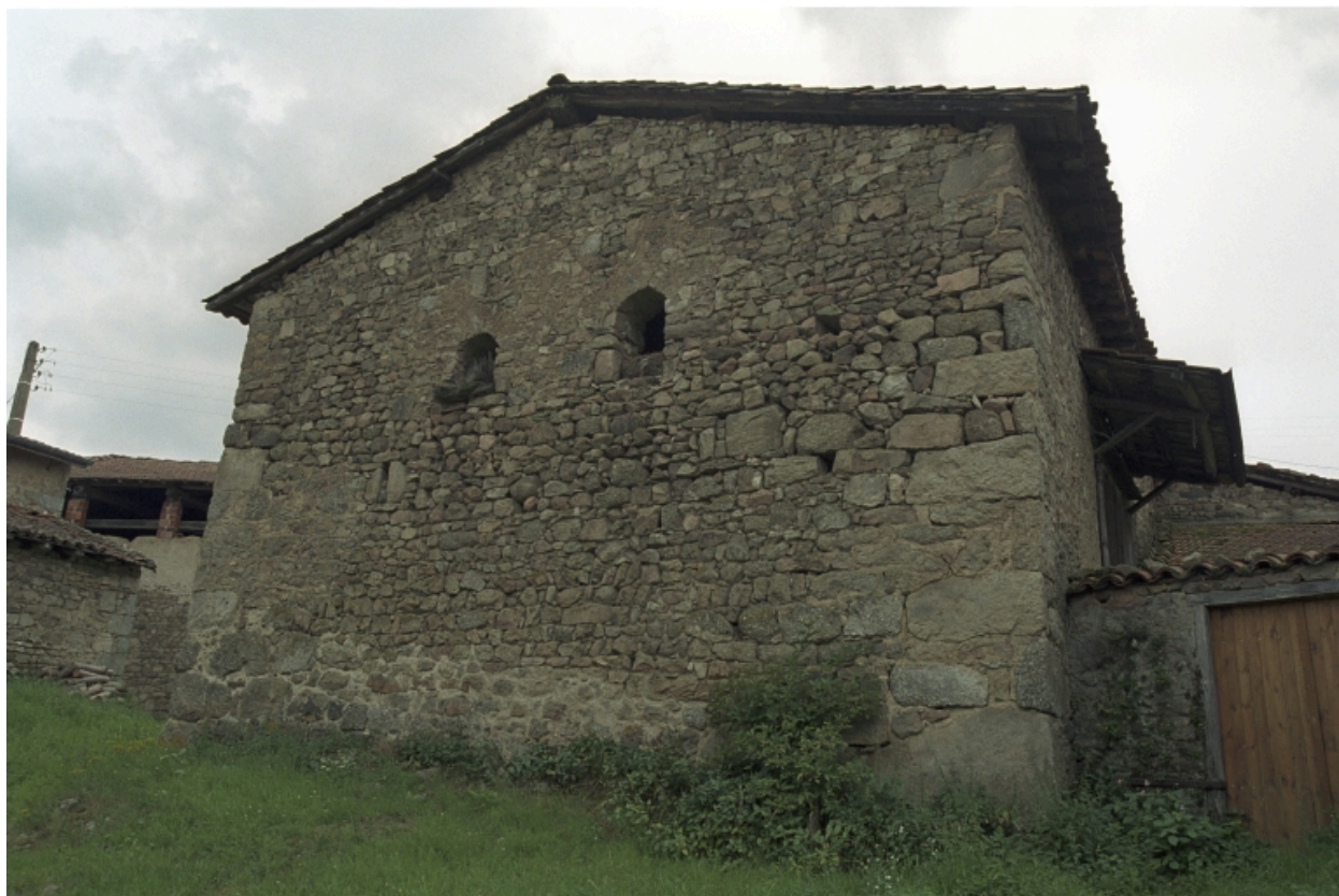
Saint-Laurent-Rochefort, Chazelles-bas (1987 C3 767, 967), type A1. Pignon de la deuxième grange-étable.
