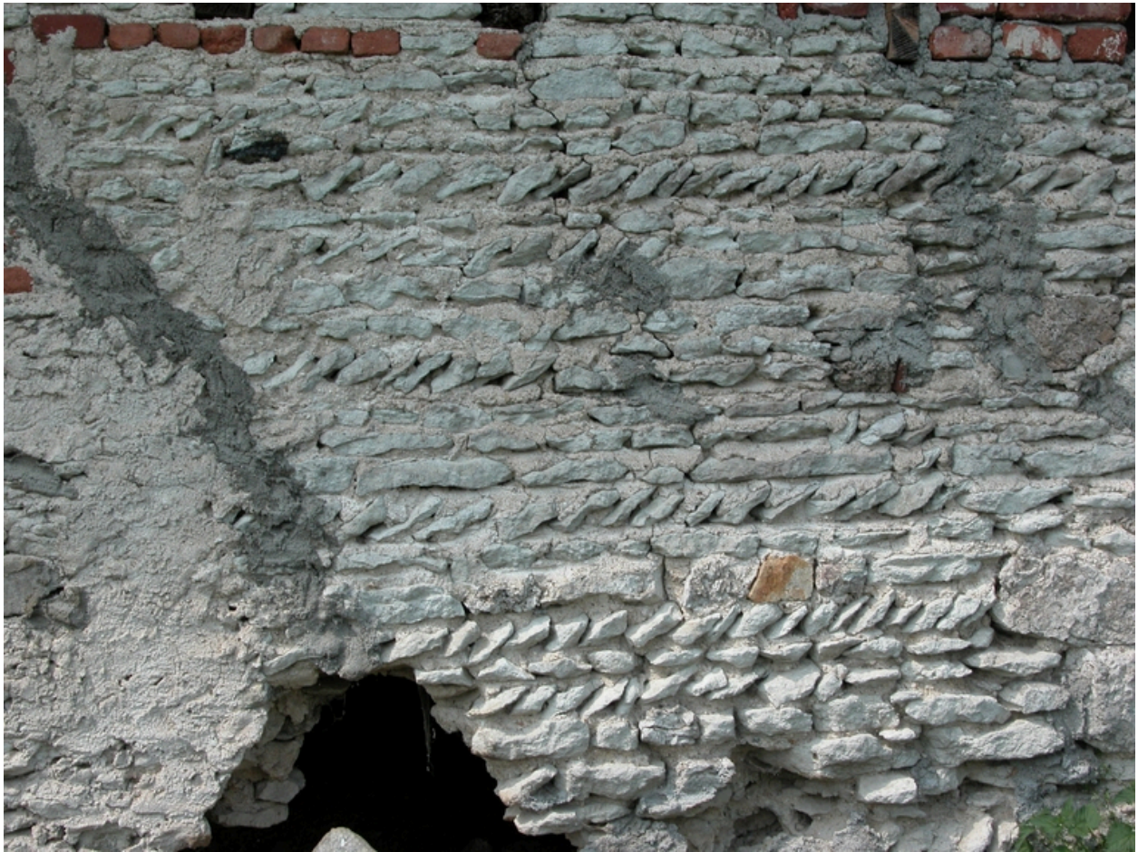
Vestige de pigeonnier (?) à la Loge (1986 B2 95). Détail de maçonnerie.
