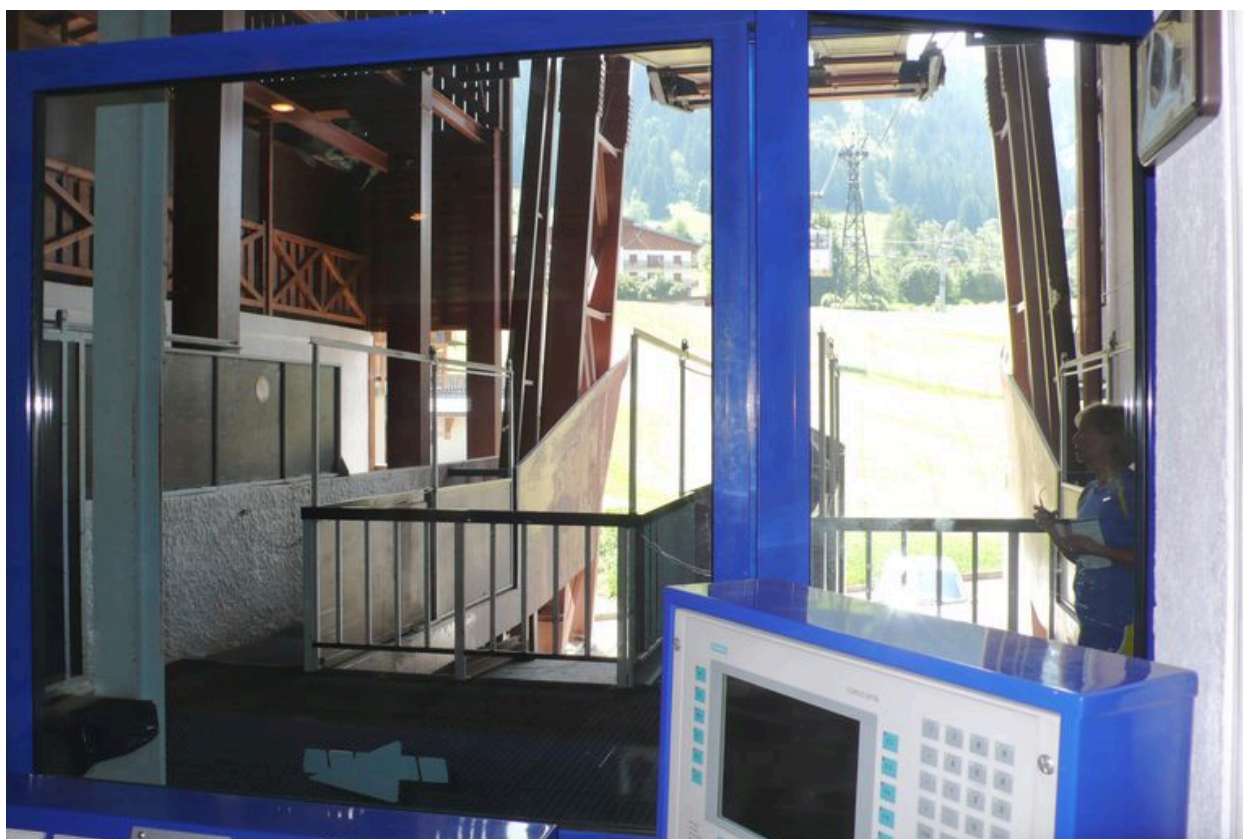
Gare inférieure. Etage du mécanisme
