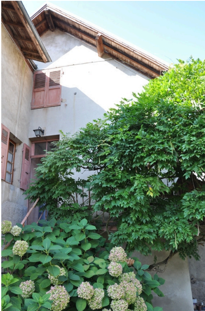
Vue du pignon est du moulin avec escalier d'accès, 2009.
