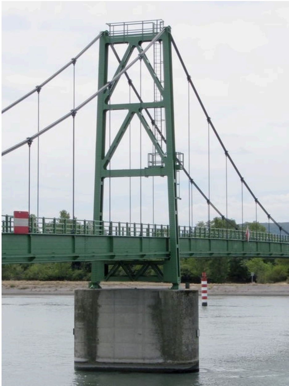
Pylône central, face amont (depuis la rive gauche)
