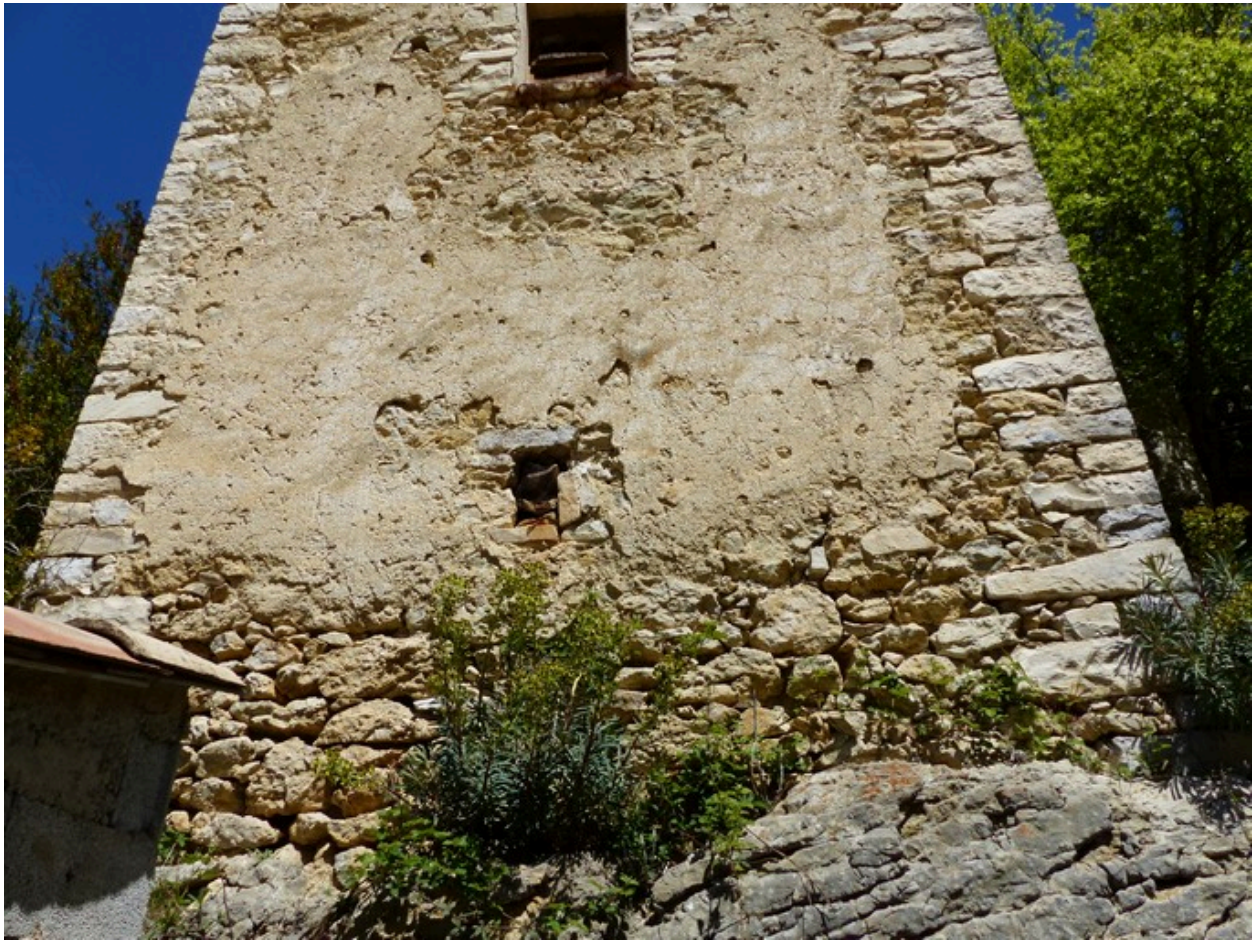
Pignon sud, partie basse.
