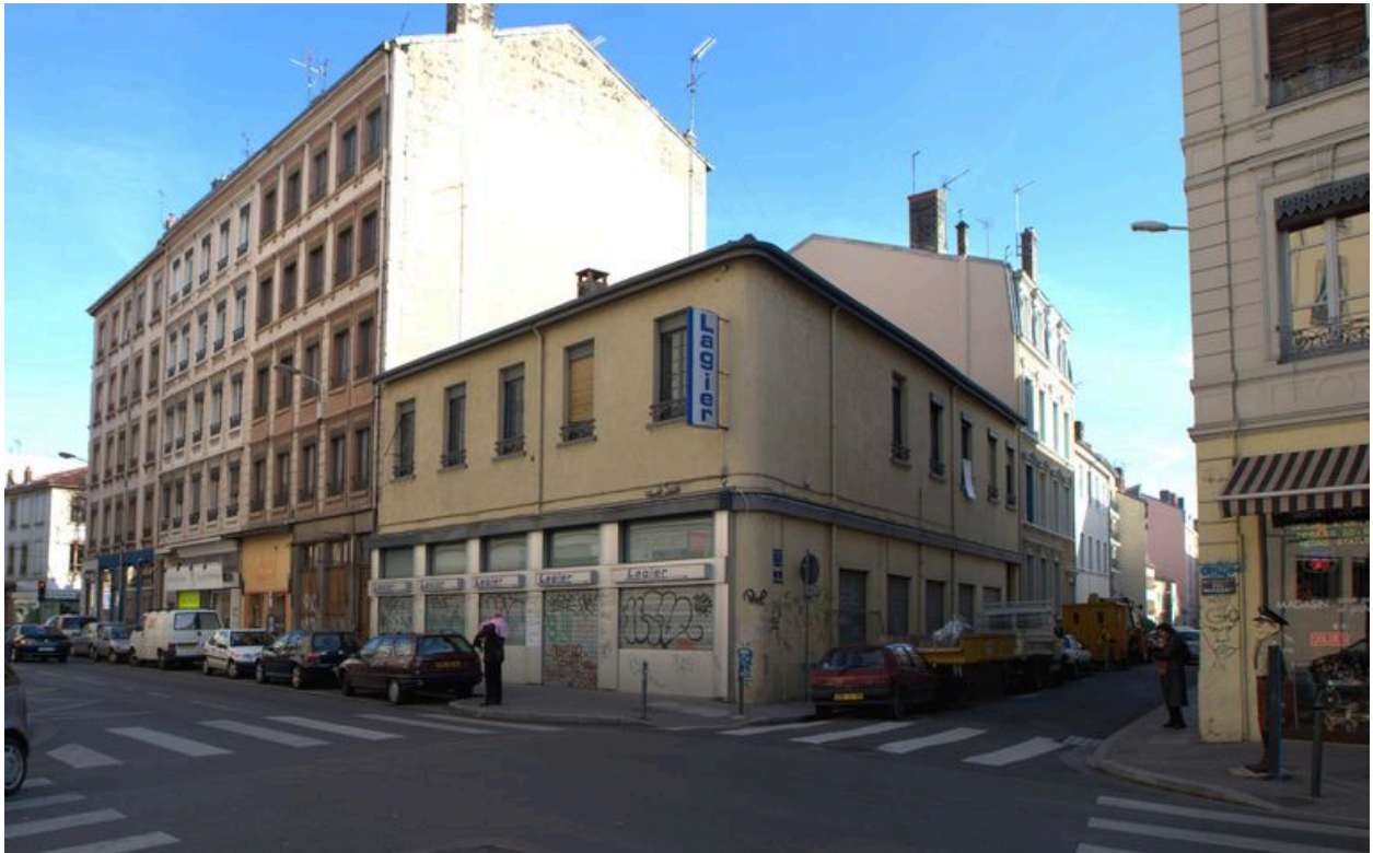
Vue générale prise du sud-ouest
