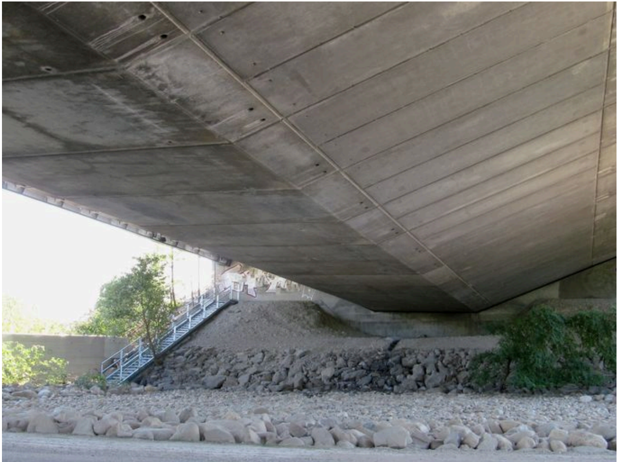
Culée gauche, de dessous, vue générale (depuis la rive gauche)
