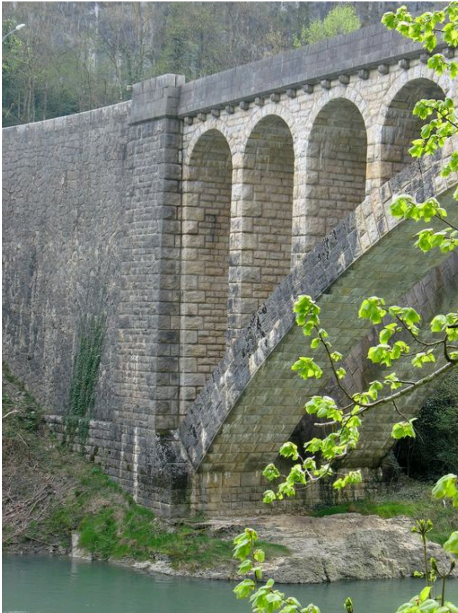
Vue partielle face amont : culée rive gauche
