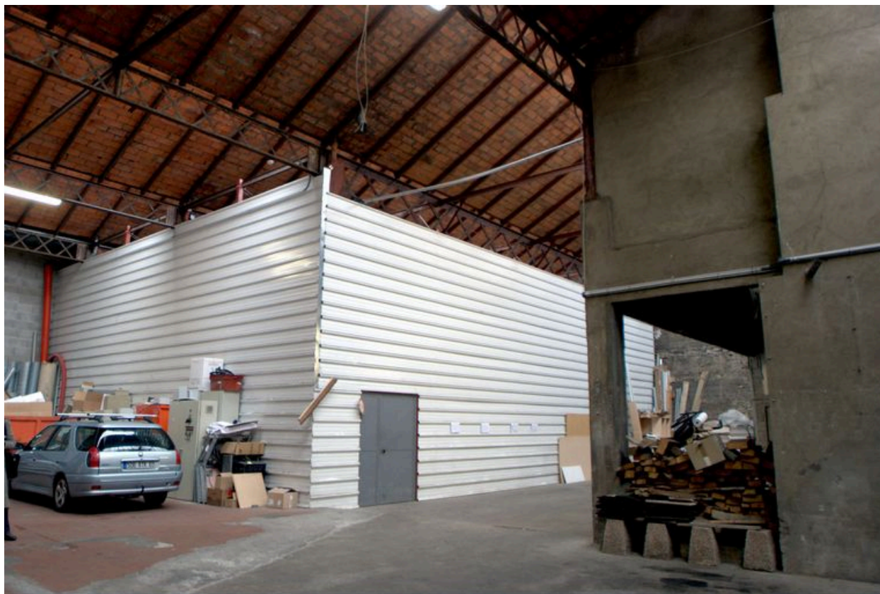
Entrepôts construits dans la cour
