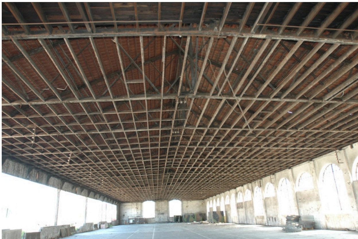
Charpente de la grande halle
