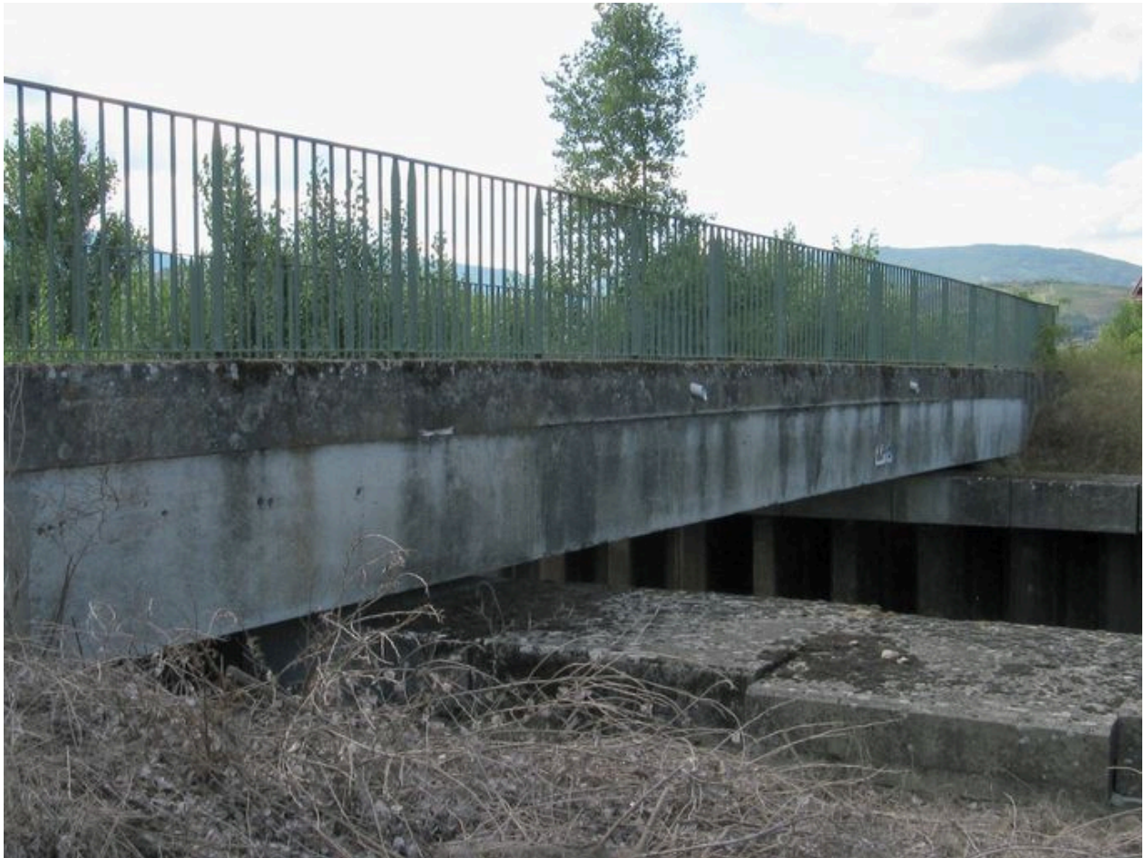
Second ponceau : vue générale, face amont
