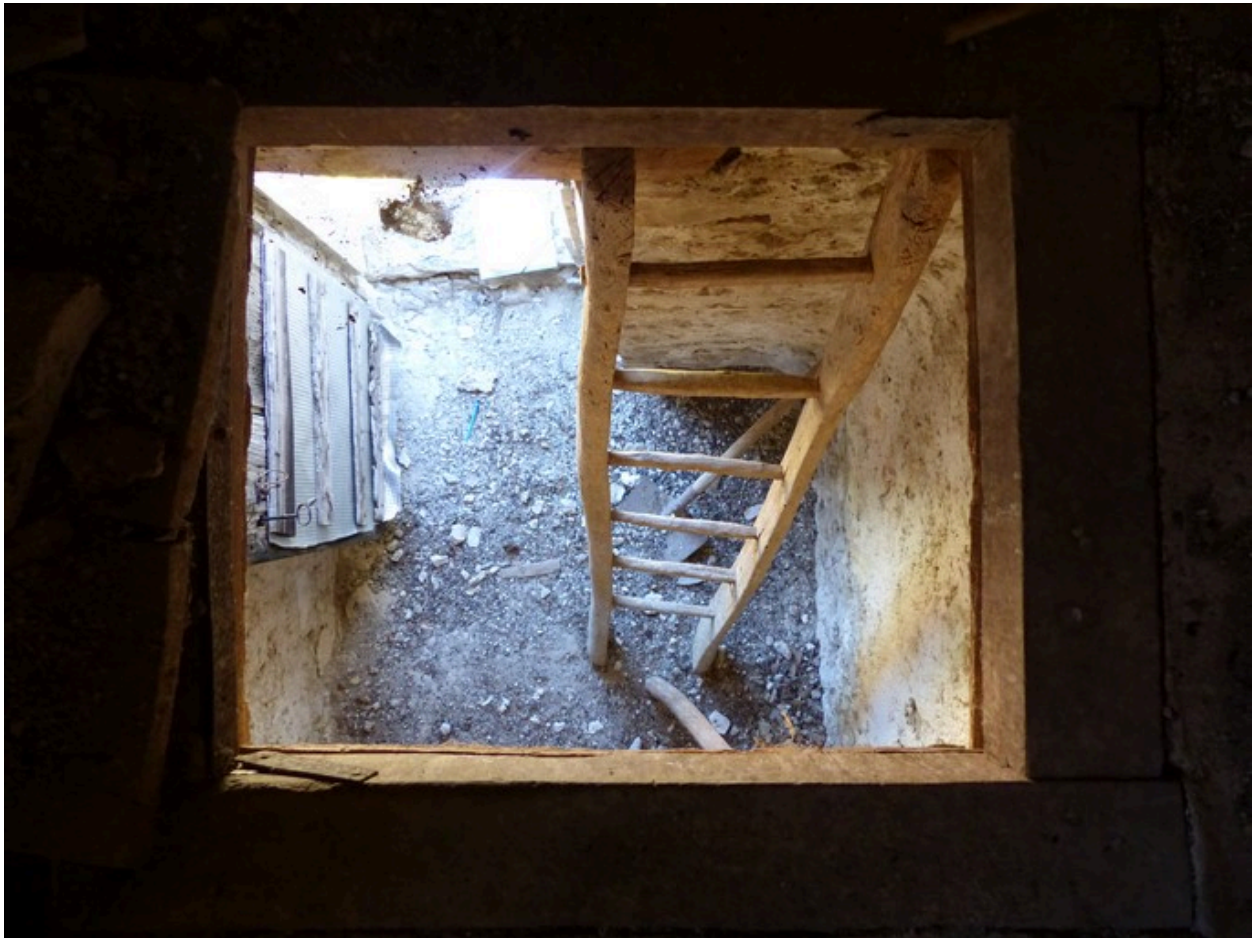
Etage de comble. Angle nord-ouest, trappe d'accès.
