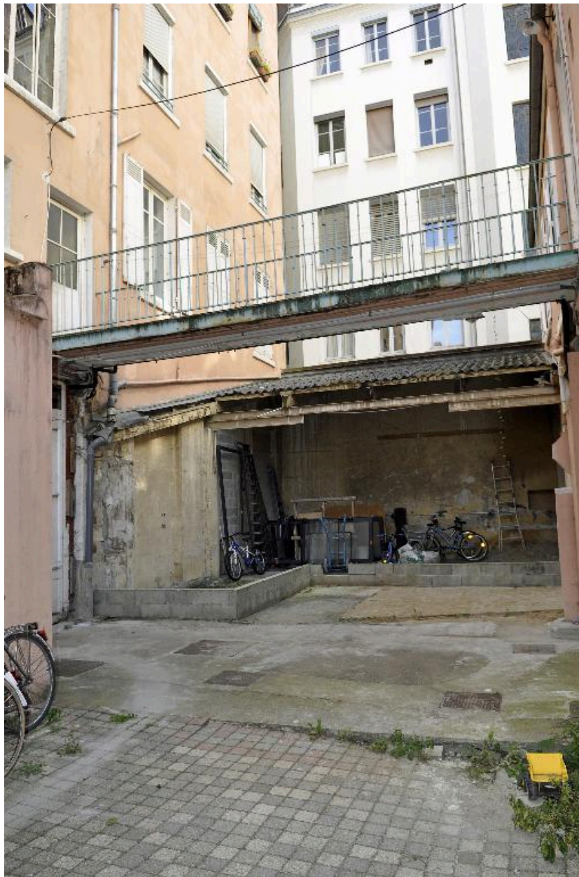
Vue de la cour : passerelle donnant accès à l'étage de l'immeuble sur cour
