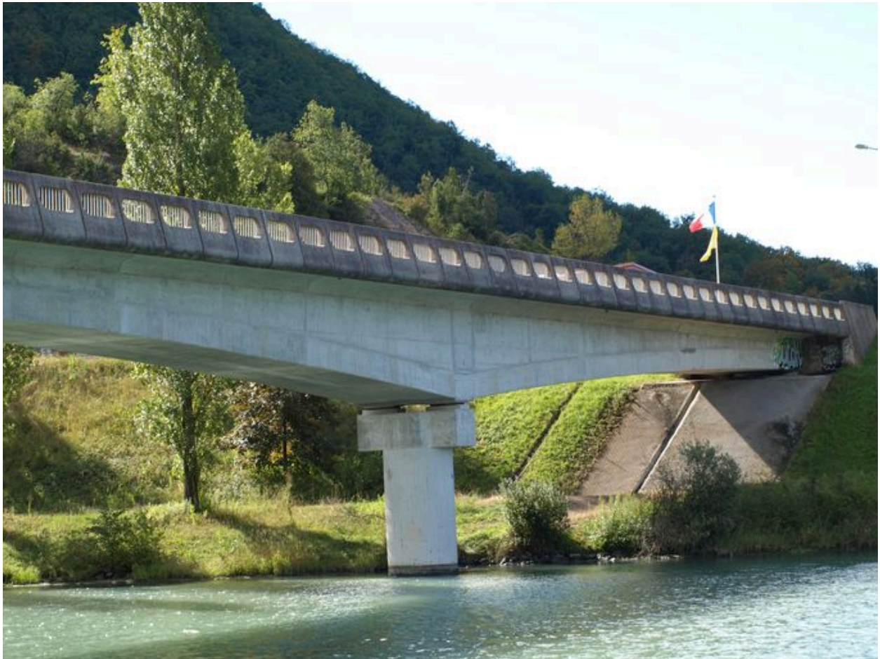
Travée de la rive gauche, face aval (depuis la rive droite)
