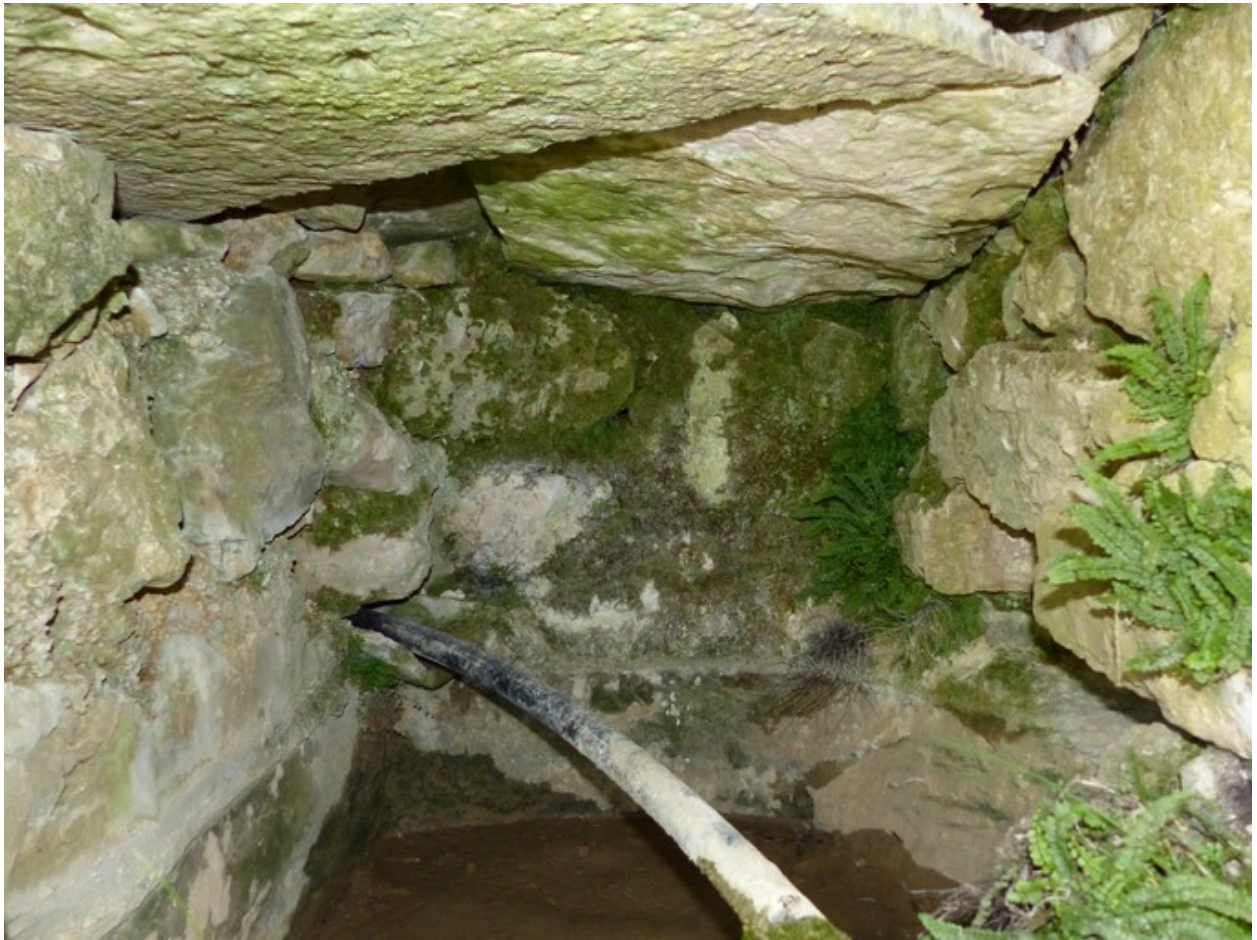
Angle nord-ouest, bassin de décantation. Vue de volume.
