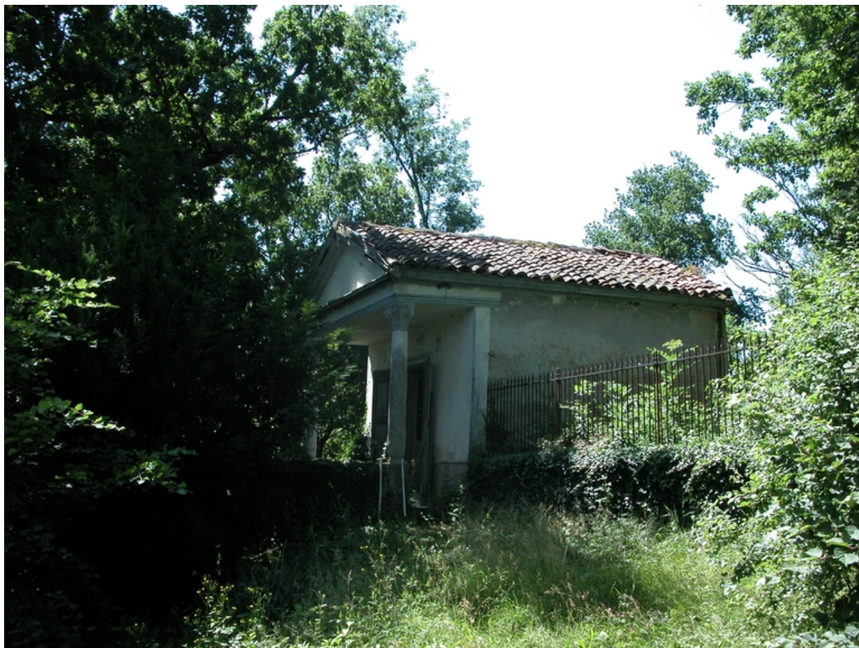
Vue de la chapelle depuis le nord-ouest.
