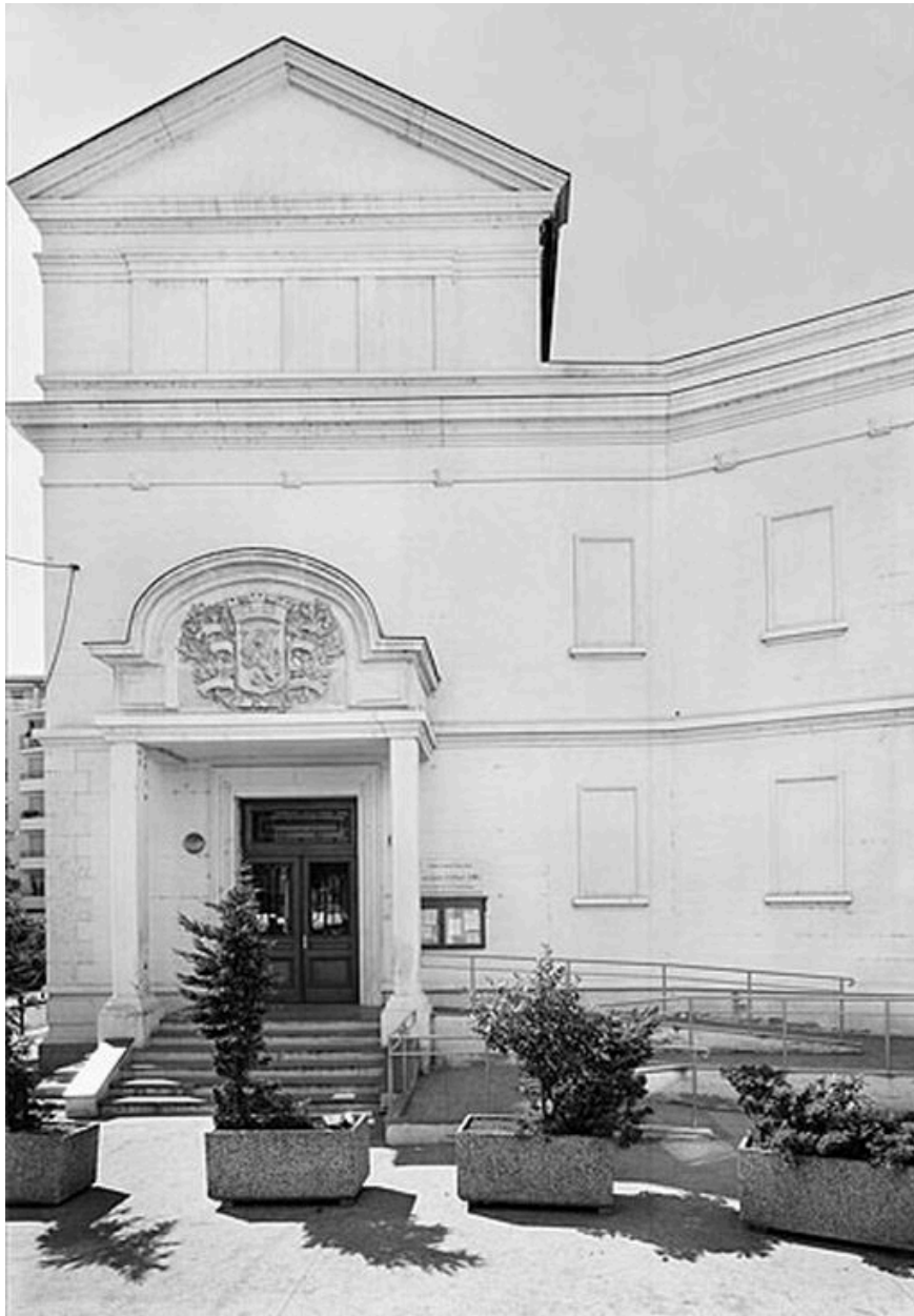
Vue générale du pignon de l'école maternelle
