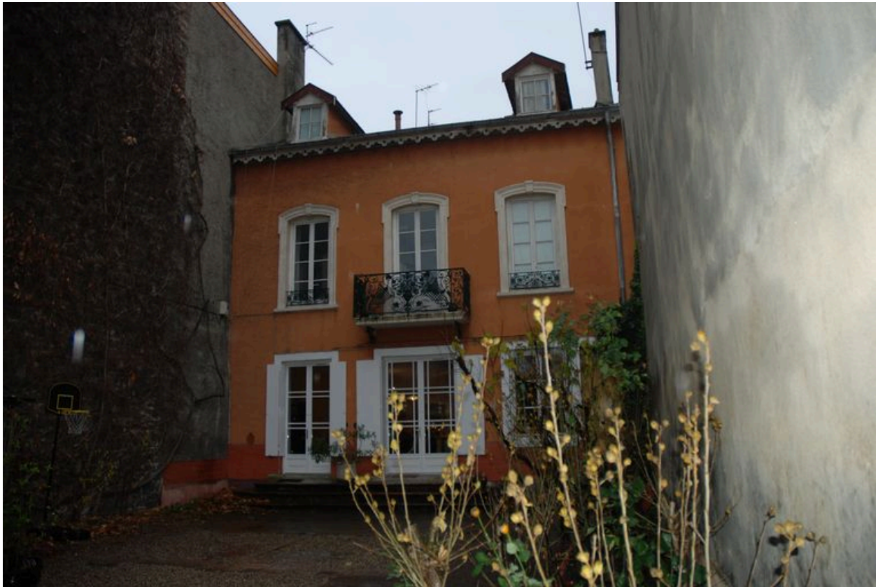
Vue générale depuis la cour.
