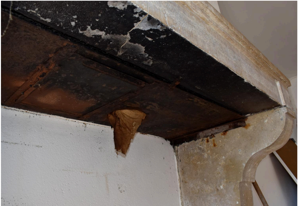
Détail de la cheminée de la cuisine.
