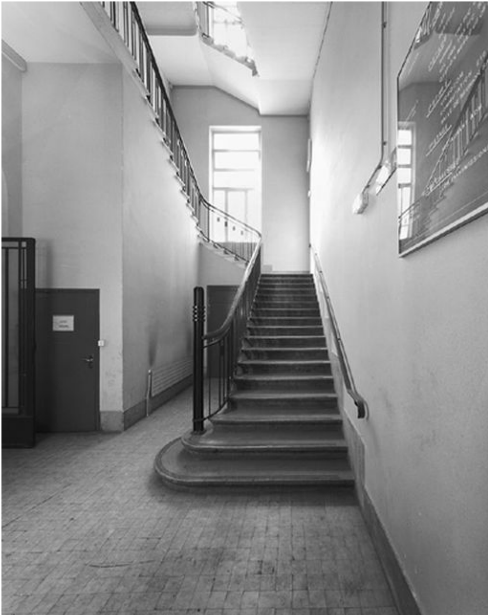
Escalier sud vu depuis le palier du rez-de-chaussée
