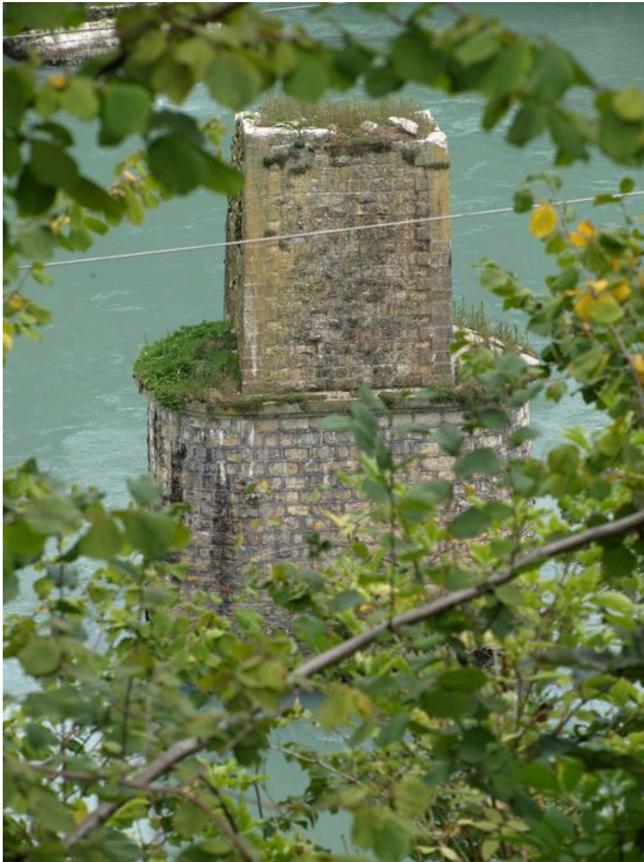
Vestiges des piles, vue partielle (depuis la rive droite)
