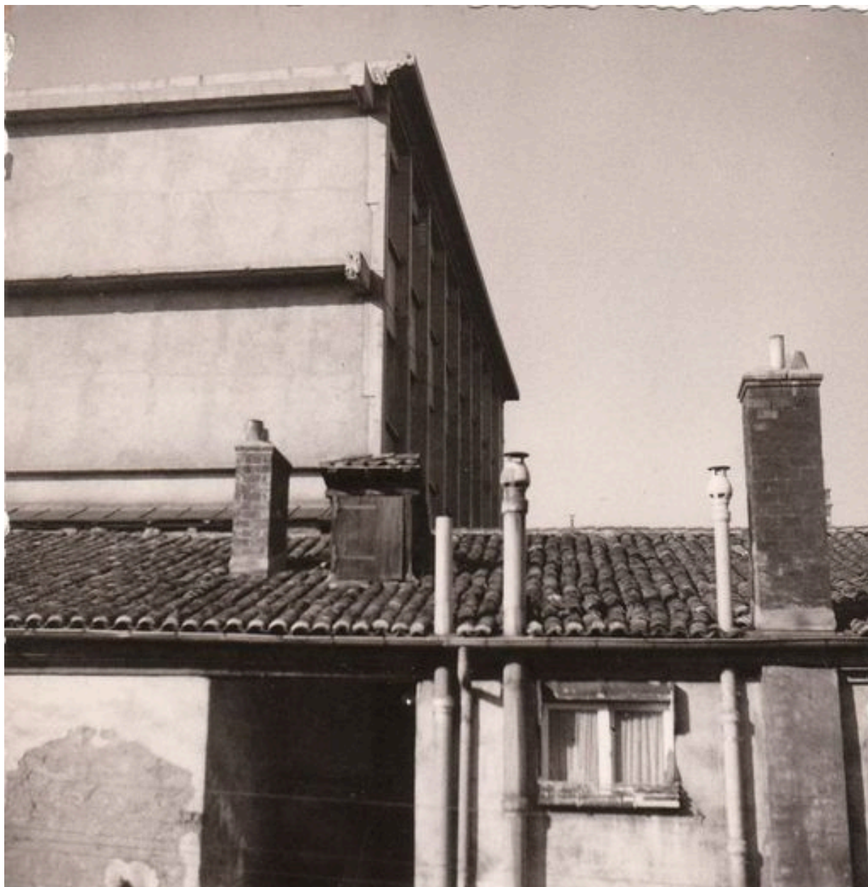
Bâtiment sur cour avant démolition, photographie ancienne, 1970-1971
