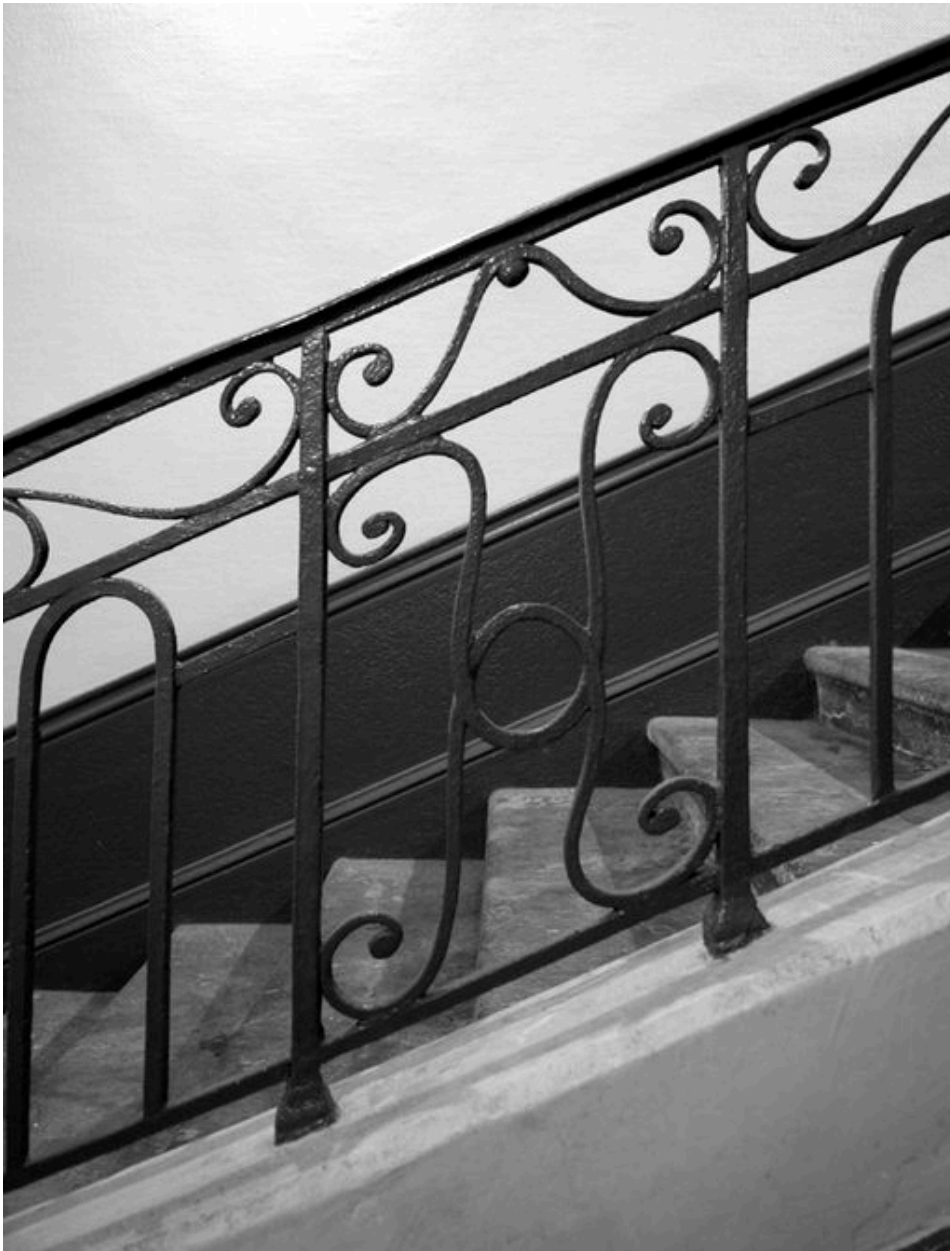
Escalier, détail de la rampe.
